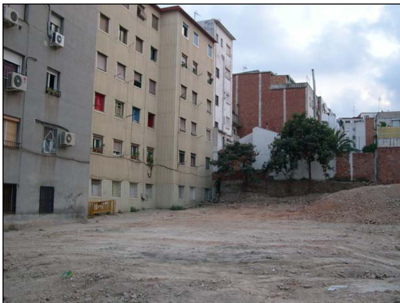
30. Solar un cop enderrocada la masia.
