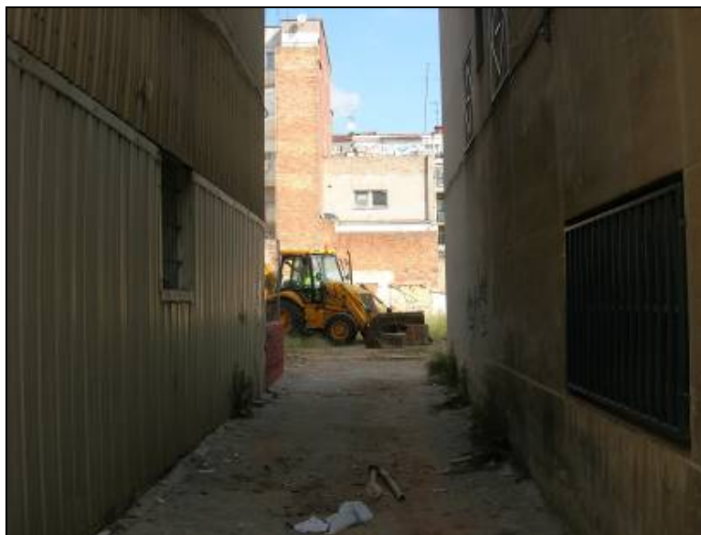
38. Passadís d'entrada del solar.
