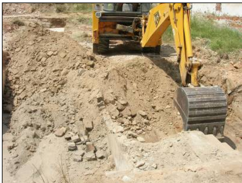
67. Màquina buidant el soterrani.
