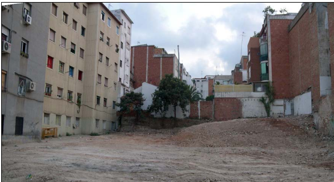
35. Panoràmica de la zona oest del solar un cop realitzat l'enderroc.
