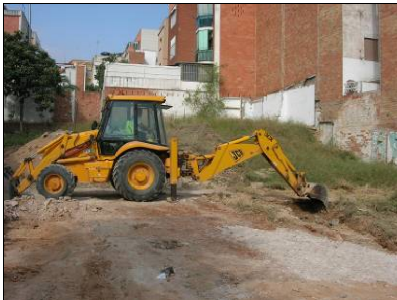
112. Màquina iniciant la Rasa3.
