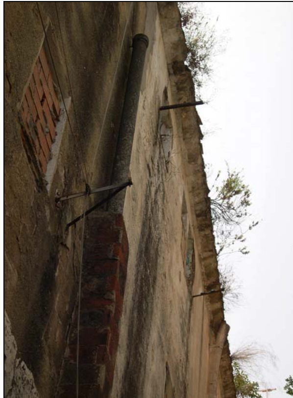
28. Vista superior de la façana nord de la masia de Can Grau.
