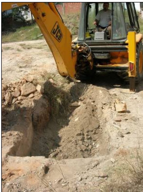
50. Màquina iniciant el rebaix de la Rasa 0.
