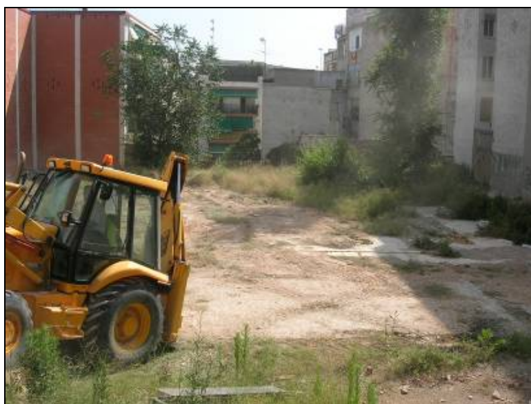
47. Vista general del solar abans d'iniciar les actuacions.
