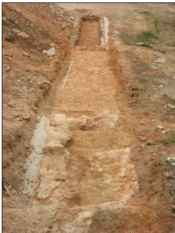
125. Rasa 4 finalitzada. Vista general de les estructures.
