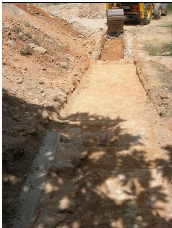
124. Vista dels treballs de la rasa 4.
