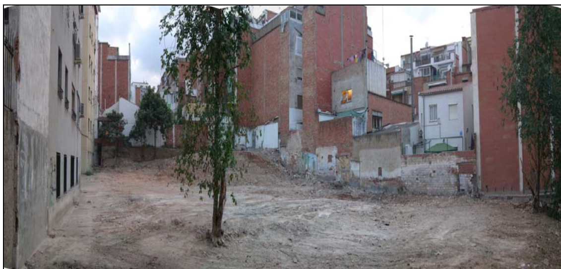
33. Panoràmica de la zona oest del solar un cop realitzat l'enderroc.
