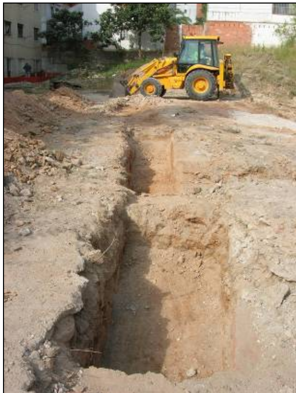
83. Buidat del segon tram de la Rasa1.
