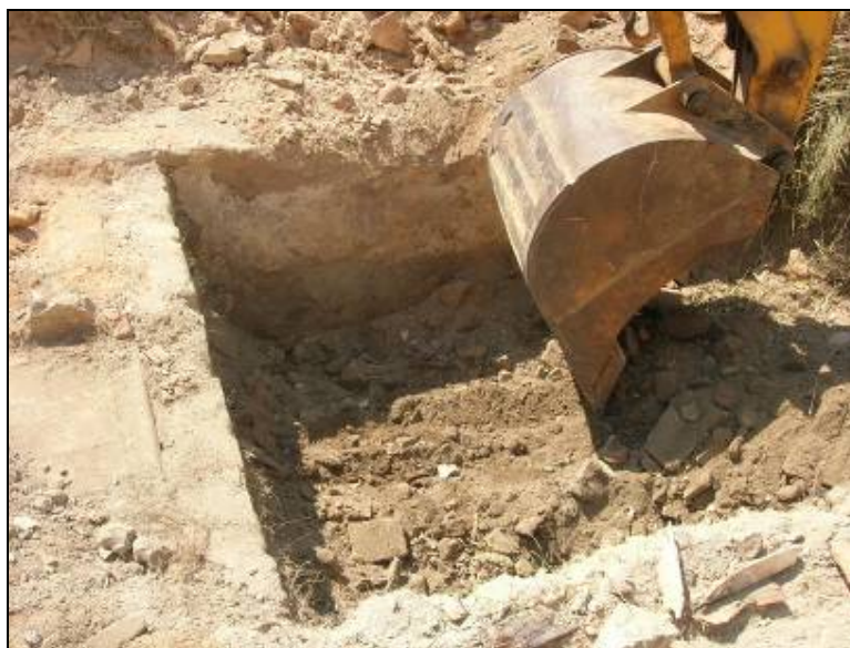
51. Màquina iniciant el rebaix de la Rasa 0.
