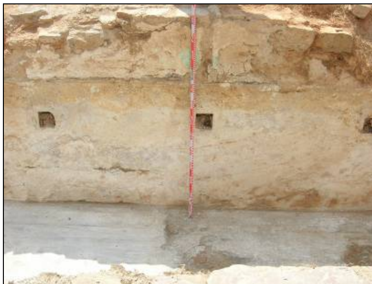
60. Detall de l'alçada del mur del soterrani UE003.
